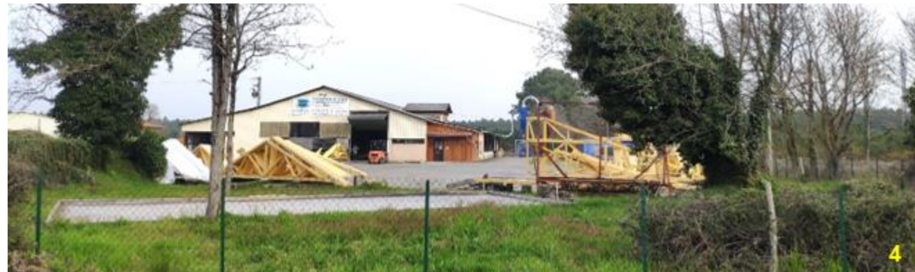
Société de charpenterie/menuiserie à l'Ouest de la zone d'implantation potentielle (source : Néodyme)
