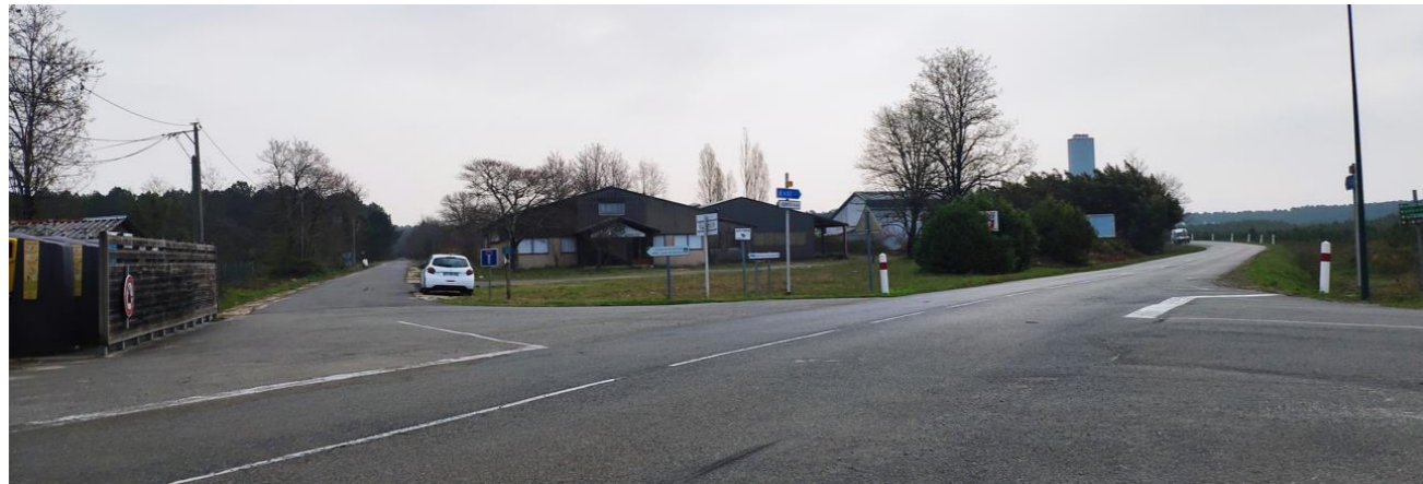
PDV Numéro 1 ETAT EXISTANT – Photo - Vue depuis l'intersection RD41 et Chemin des Sables à l'Ouest de la zone d'implantation.
